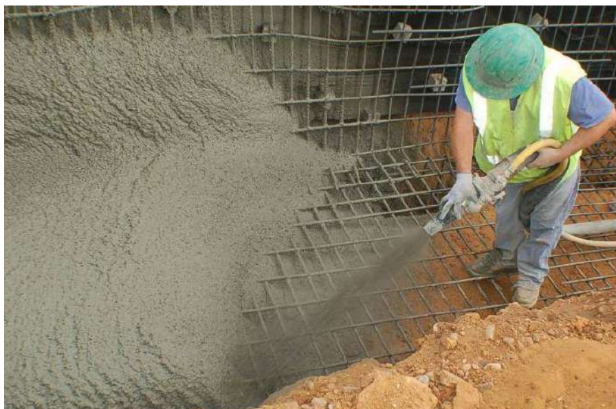
Рисунок 1 – Торкретирование откоса дамбы – эффект гидротехнических плит
