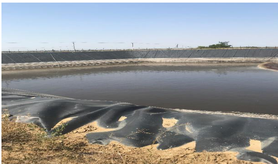
Рисунок 4.6 – Построенный биологический реактор в ООО «Союз-Агро» для накопления и окисления жф
