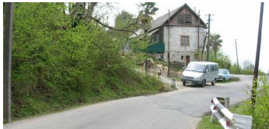
Рисунок 1.5 – Общий вид на участок автомобильной дороги Санаторий «Прогресс» – село Каштаны, км 2+750 (2007 г.)
