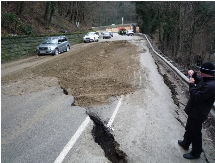
Рисунок 1.1 – Оползень на км 56+680 автомобильной дороги А-147 Джубга – Сочи (февраль 2011 г.)
