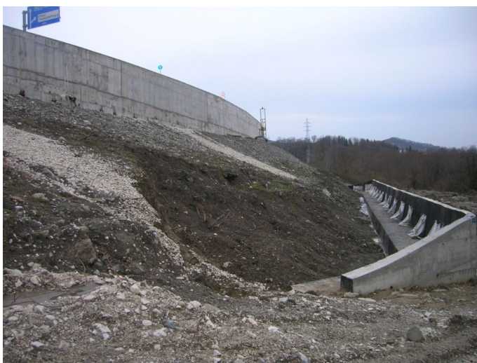
Рисунок 1.4 – Строящиеся свайно-анкерные удерживающие сооружения на низовом склоне на ПК 82 автомобильной дороги на Обходе г. Сочи
