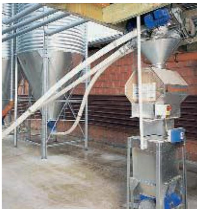
Рисунок 7.6 – Дополнительный бункер с весами *FW 99B*
