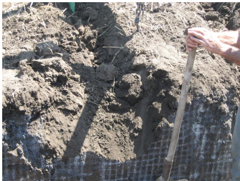
Рисунок 6.16 – Вид области разрыхления от стойки КАО-2
