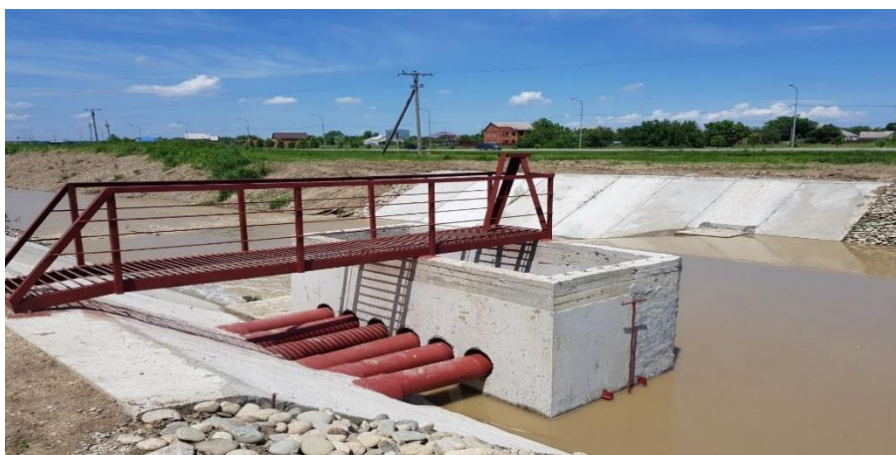
Рисунок 5.2 – Водозаборное сооружение на Новокубанском канале в ООО «Южная плодоовощная компания»
