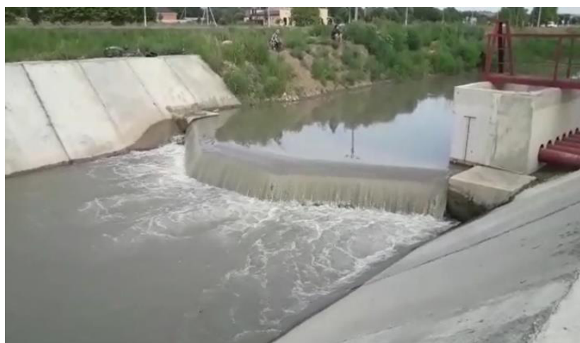
Рисунок 5.1 – Водоподпорное сооружение на Новокубанском канале
