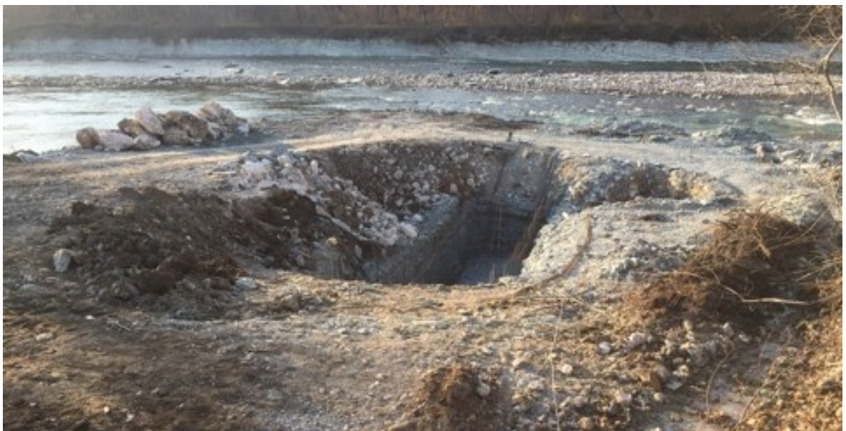
Рисунок 4.12 – Внешний вид котлована под водозаборное сооружение
