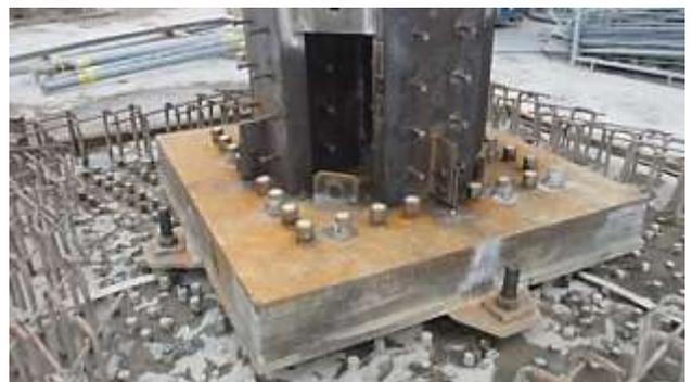
Рисунок 2.53 – Узел опирания сталебетонной колонны на коробчатый фундамент
