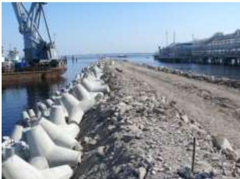
Рисунок 1.10 – Укрепление берега тетраподами
