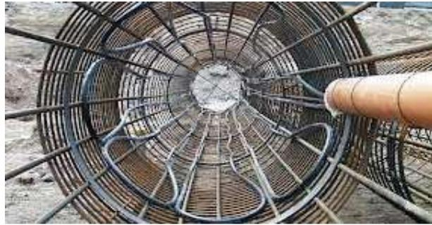
Рисунок 2.29 – Арматурный каркас и геотермальный контур в свае
