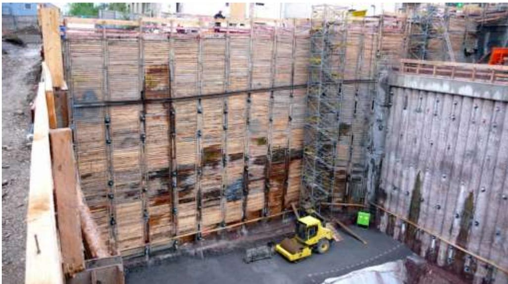
Рисунок 6.4 – Госпиталь Св.Ольги (Штутгарт, Германия): сочетание различных типов ограждения котлована и высачивание грунтовых вод по трещинам в породах
