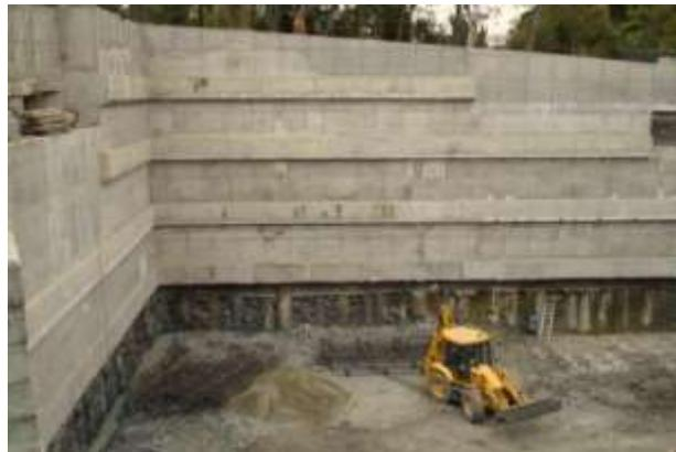
Рисунок 2.42 – Грунтовые анкера при креплении подпорной стены глубокого котлована
