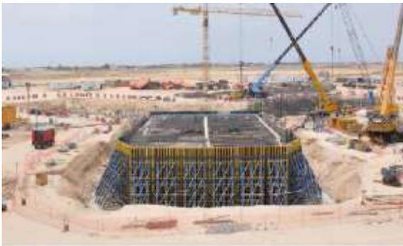
Рисунок 2.63 – Этап армирования фундаментной плиты «Кингдом Тауэр»
