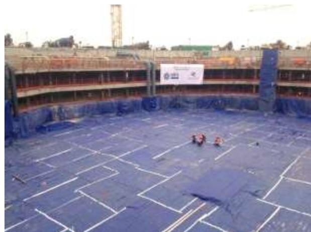
Рисунок 2.57 – Армирование фундаментной плиты здания «Лахта Центр»
