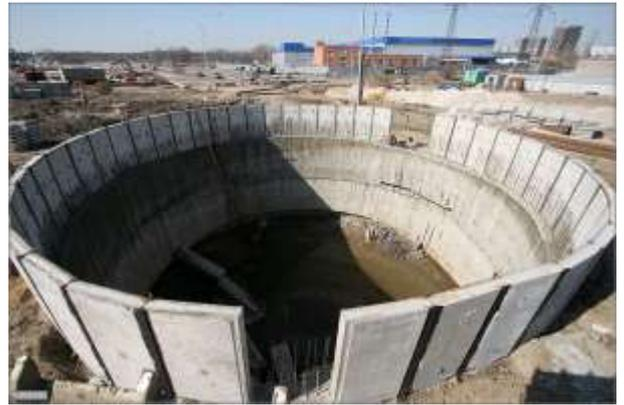
Рисунок 2.44 – Общий вид фундамента в виде опускного колодца
