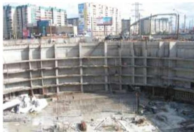
Рисунок 2.37 – Этап производства работ по устройству глубокого котлована с использованием ограждения по методу «стена в грунте»
