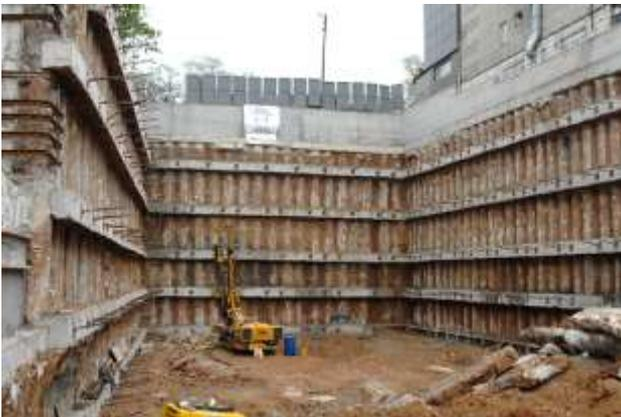
Рисунок 2.33 – Ограждение глубокого котлована из Jet-свай
