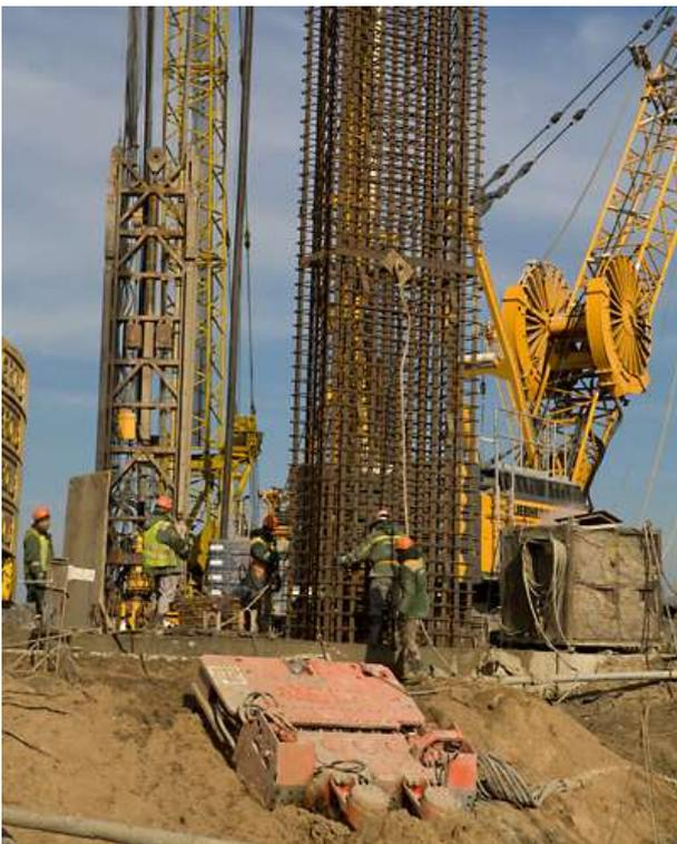
Рисунок 2.24 – Изготовление баррет
