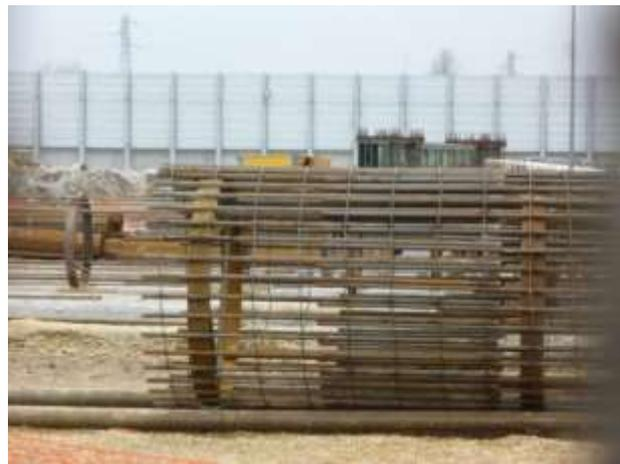
Рисунок 2.25 – Арматурный каркас сваи диаметром 2000 мм
