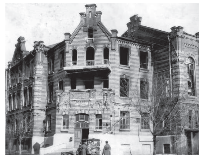
Разрушенное здание института на ул. Буденного, 10
