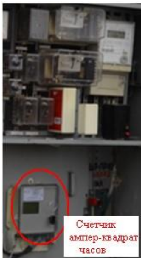
Рисунок 3.1 – Специализированный прибор «Определитель ампер-квадрат-часов» (АкЧ-В-1(м) – 5А АС), установленный в высоковольтной ячейке фидера ГЦ-11 на питающем центре ПС «Геймановская»
