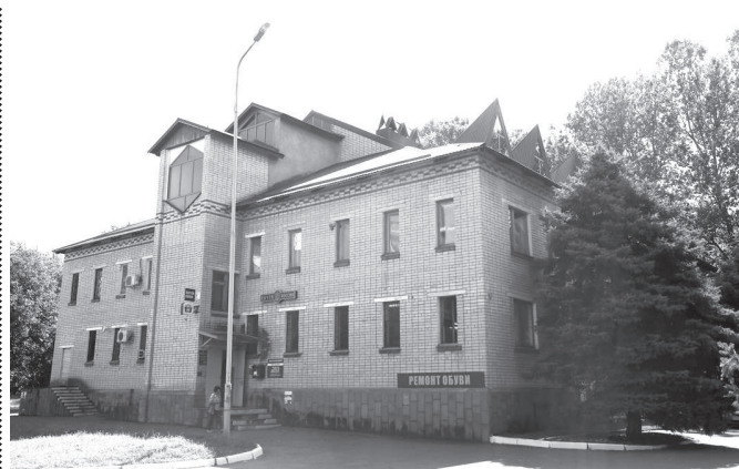
Блок бытового обслуживания
