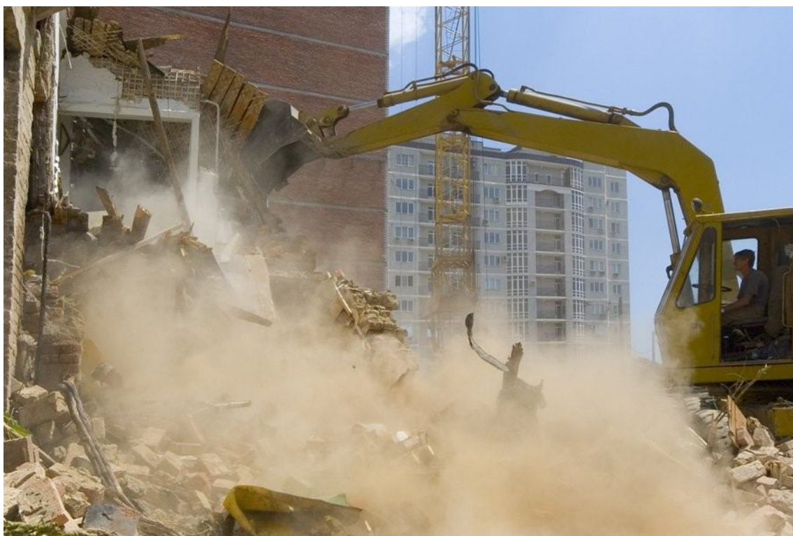
Рисунок 1 – Пример образования пыли при строительных работах
