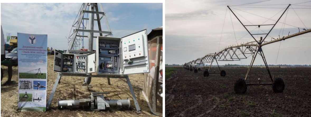
Рисунок 1.1 — Устройство системы управления дождевальными машинами «Кубань-ЛК1»
