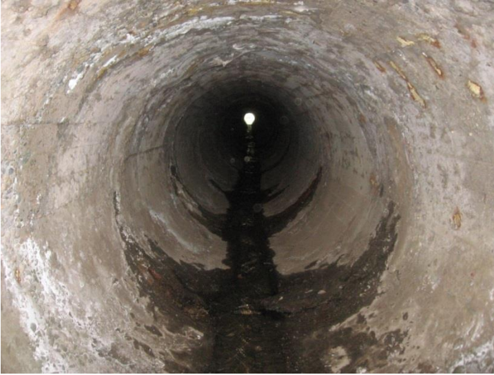
Рисунок 3.4 – Водоподающее сооружение внутрихозяйственной сети в удовлетворительном состоянии без дефектов
