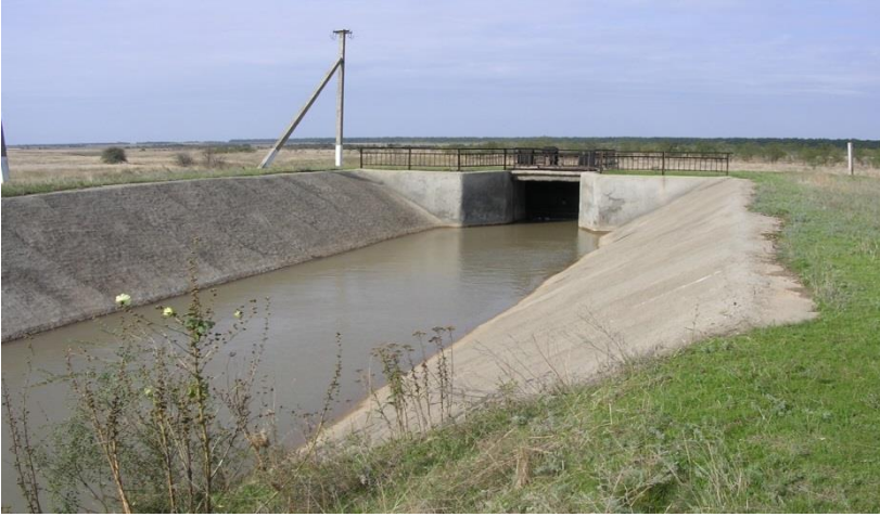
Рисунок 2.15 – Нижний бьеф шахтного перепада на МК-1 ПК – 355
