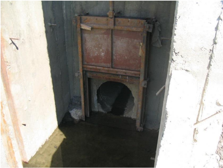
Рисунок 3.16 – Обследуемое водоподающее сооружение внутрихозяйственной сети
