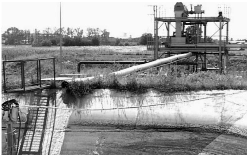
Рисунок 4.4 — Конструкция технологического устройства отделения взвешенных веществ от производственных сточных вод
