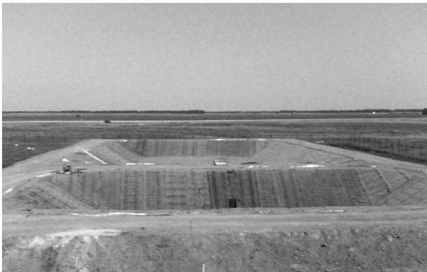
Рисунок 4.5 — Технологическая конструкция аэрируемых прудов для биологической очистки промышленных стоков
