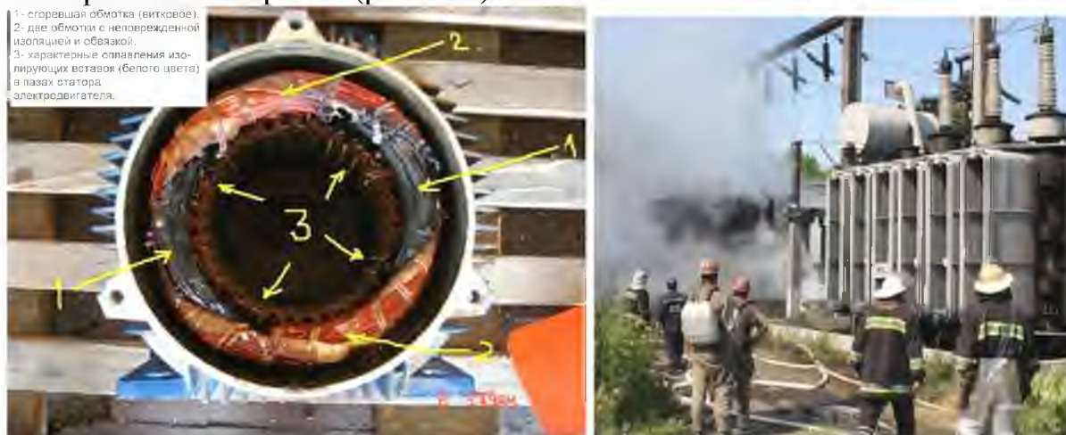
Рисунок 1.11- Выход из строя обмотки статора электродвигателя и повреждение трансформатора
