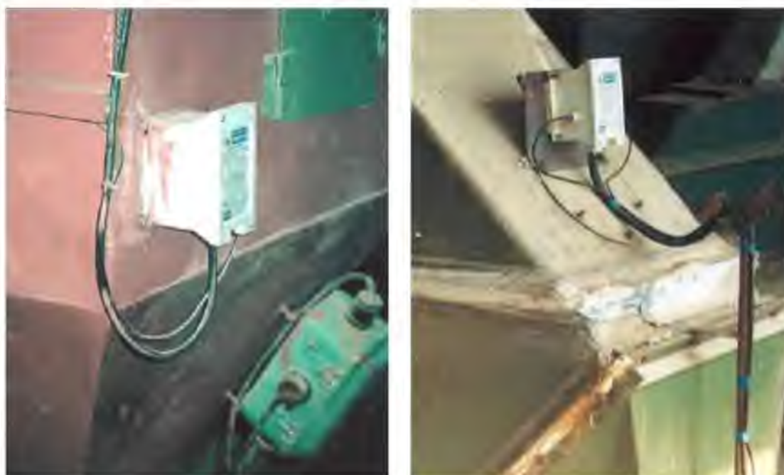
Рисунок 4.85– Установка датчика уровня в бункере и контроль подпора в головке нории
