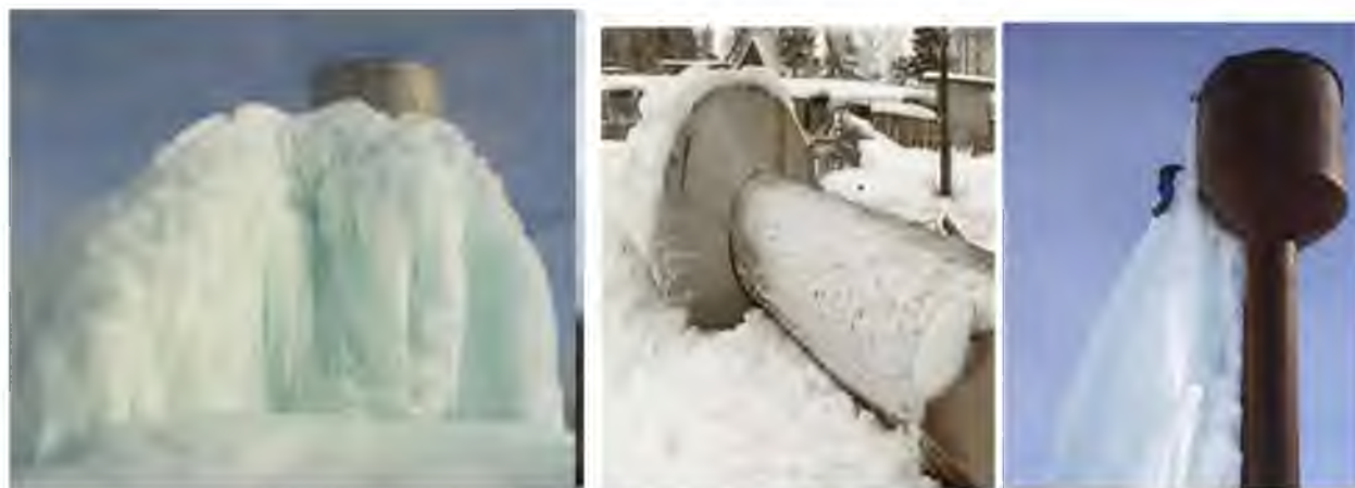
Рисунок 2.60– Обмерзание датчиков и образование наледи на башне
