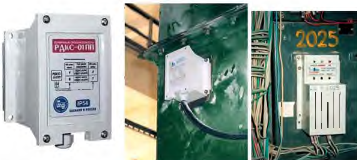
Рисунок 4.88 - Внешний вид прибора контроля скорости и изображение установки его частей на объекте автоматизации и в щите управления
