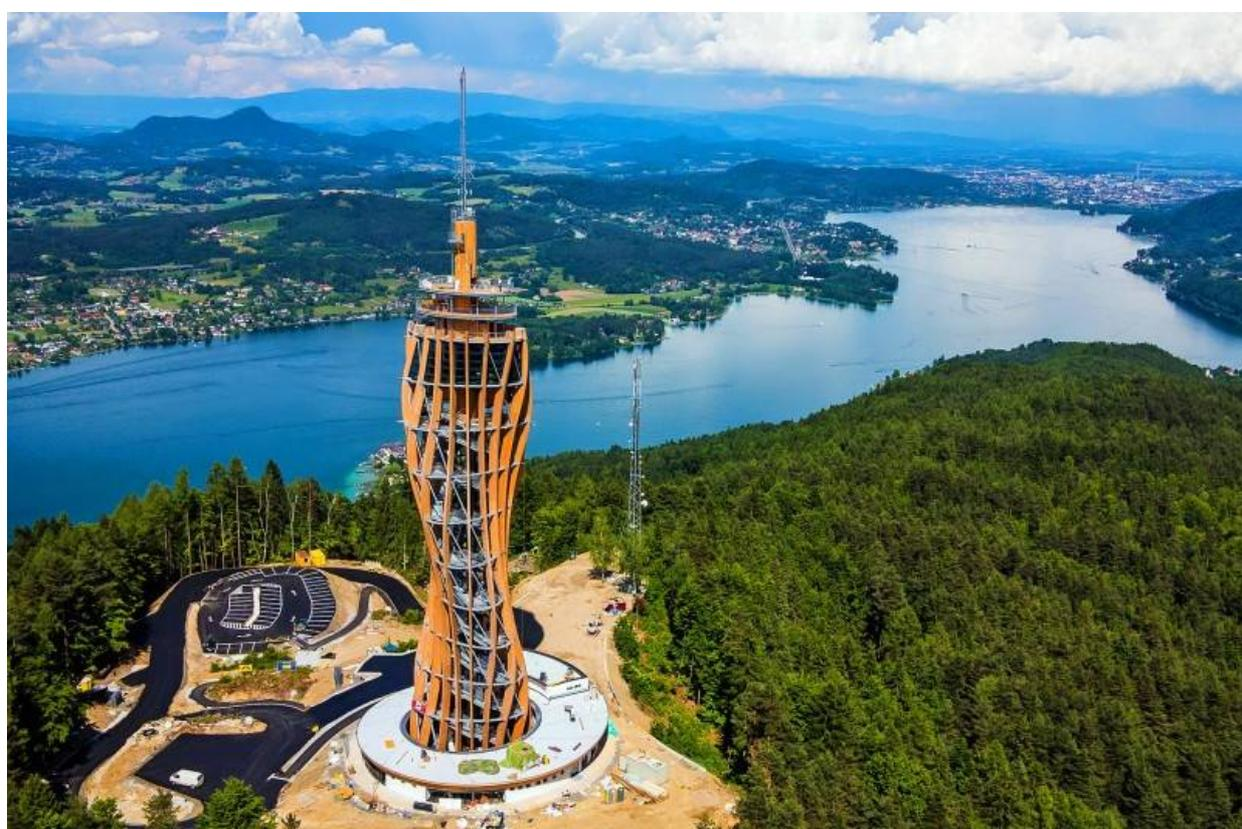
Рисунок 1.6 – Обзорная башня Пирамиденкогель в Австрии – уникальная башня высотой 100 м из дерева и стали, так называемая «лестница в небо». Конструкция из клееного лиственничного бруса обеспечивает оригинальную форму здания. Располагает детской горкой длиной 120 м
