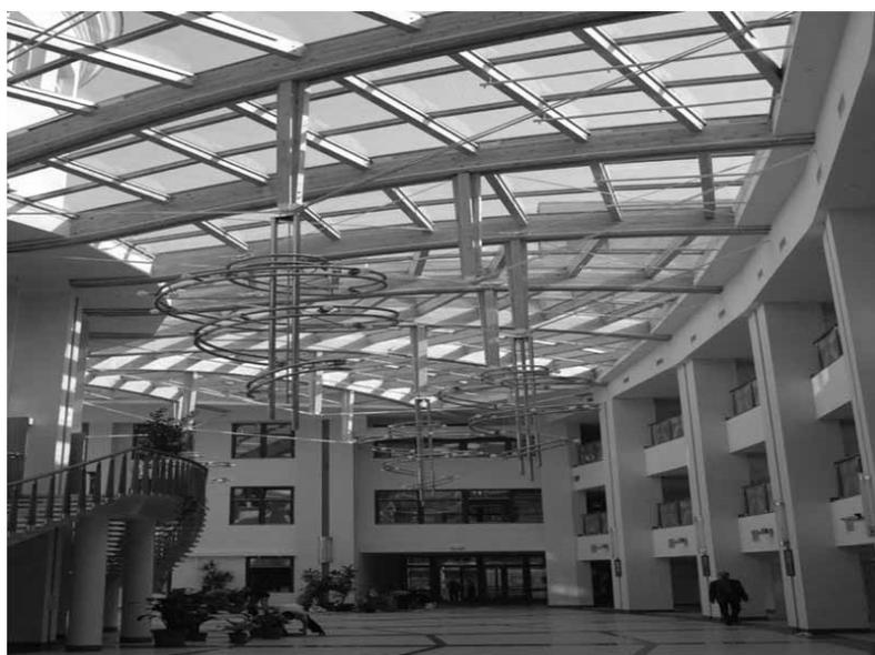
Рисунок 1.8 – Конструкция покрытия в фойе аэропорта из клеедеревянных элементов, Норвегия
