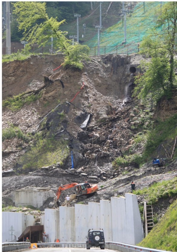
Рисунок 2. Ликвидация последствий размыва склона водами поверхностного стока с «Роза Плато» на отметке 1300 м, май 2015 года (фото авторов)
