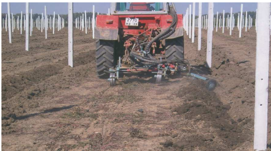
Рисунок 12 – Обновление посадочных борозд специальной фрезой после установки столбов
