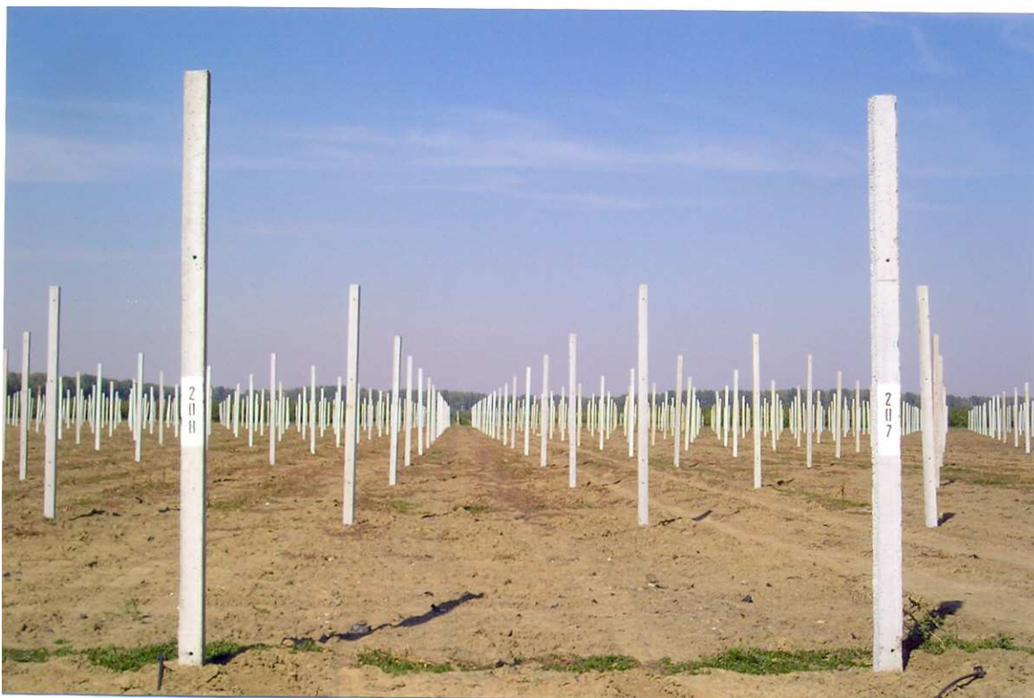
Рисунок 14. Вид плодового сада после установки железобетонных якорных и промежуточных столбов
