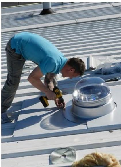
Рисунок 3 – Процесс сборки солнечного колодца
