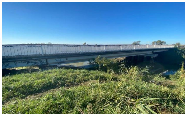
Рисунок 1 – Общий вид мостового переезда расположенный на Чибийском канале между хутором Хомуты и поселком Яблоновский
